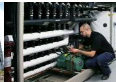
Manutenção sistema de refrigeração
