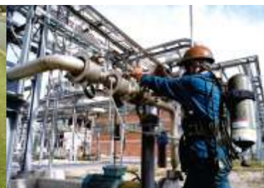
Manutenção elétrica e mecânica
