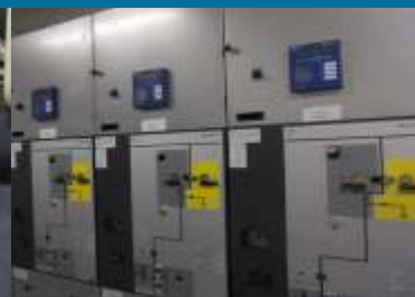
Manutenção em subestação
