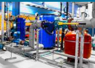
Montagem industrial eletromecânica
